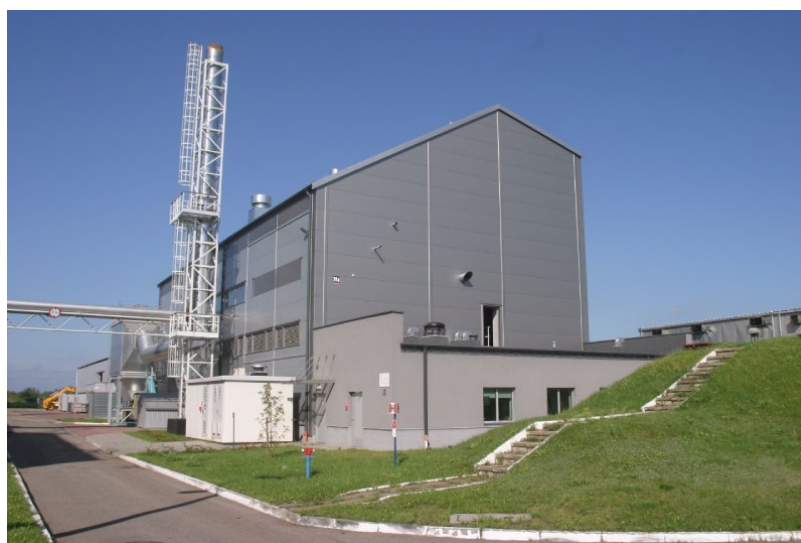
Obr. Elektrociepłownia Lębork, kogenerační jednotka na biomasu - ekologické zlepšení sítě dálkového vytápění https://pfrdlamiast.pl/bazamijskich-innowacji/lebork-elektrociepłownia-na-biomase-ekologiczne-usprawnienie-miejskiej-sieci-ciepłowniczej.html .
