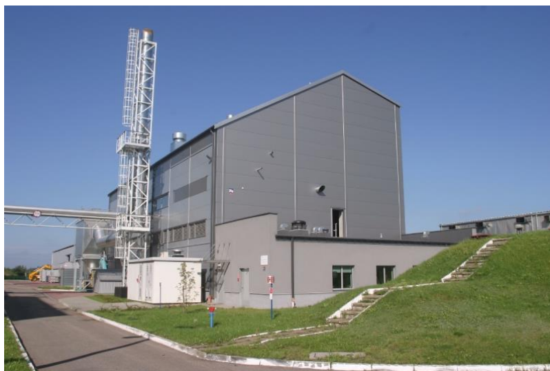
Rys. Elektrociepłownia Lębork, elektrociepłownia opalana biomasą - ekologiczna poprawa sieci ciepłowniczej źródło
