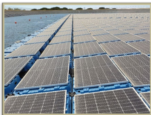
Obrázek 2: Detail plovoucí fotovoltaické instalace
